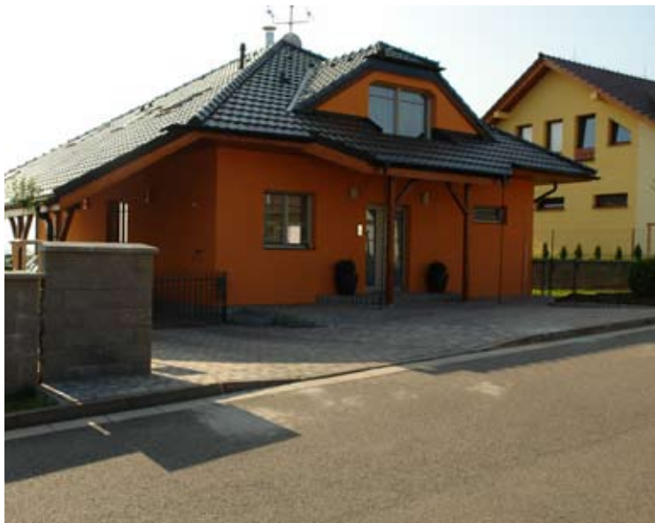
Přesah střechy chrání vstup do domu. Na střechu zvolili majitelé osvědčenou klasiku – pálené tašky Tondach a podhledy z dřevěných palubek
